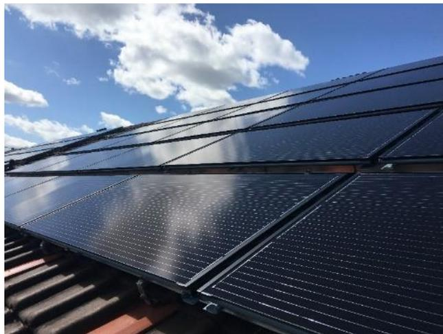
Abbildung 107: PVT-Kollektoren auf dem Dach der ES2
