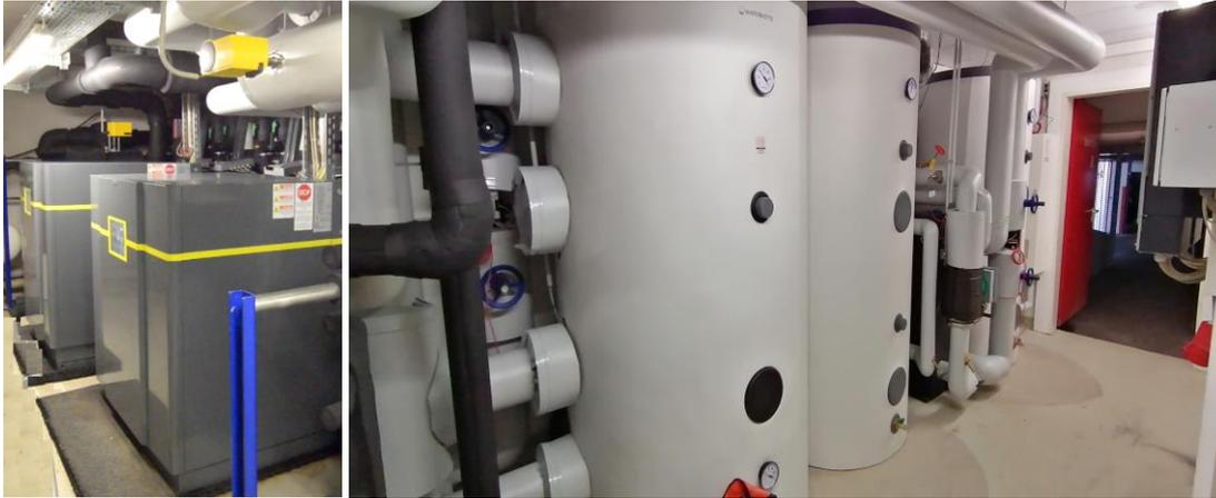
Abbildung 94: Wärmepumpen (links) und Speicher (rechts).
