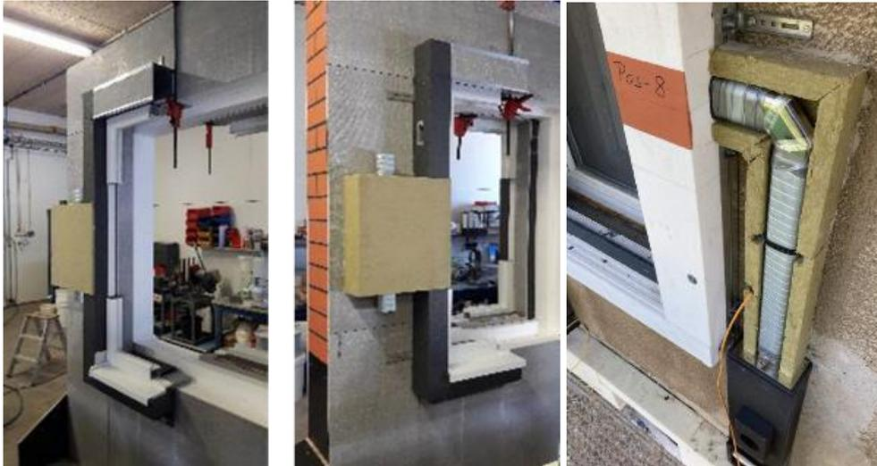
Abbildung 76: Funktionsmuster: Fassadenleitung und Fensterrahmen und finale Version in Adorf (rechts).
