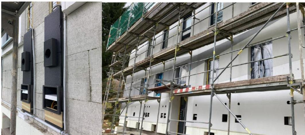
Abbildung 83: Einbausituation der Lüftungsgeräte im Sockelbereich.
