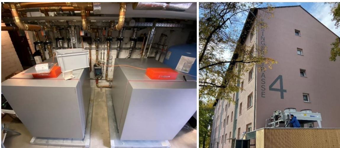
Abbildung 110: Links: Wärmepumpen-Kaskade. Rechts: Außenlufteinheit auf neu errichtetem Müllhäuschen.
