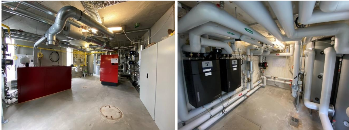
Abbildung 104: Links: Heizzentrale mit BHKW (links im Bild) und Gaskessel (Bildmitte). Rechts: Unterstation mit Frischwasserstation (links im Bild) und Pufferspeicher (rechts im Bild).
