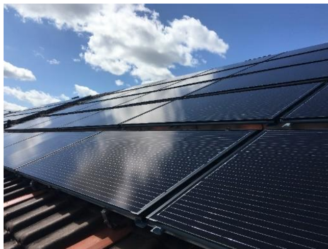
Abbildung 107: PVT-Kollektoren auf dem Dach der ES2
