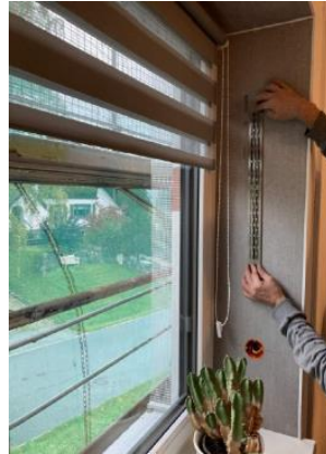
Abbildung 78: Lufteinlass mit Gitter in dem Demonstrationsgebäude in Adorf.
