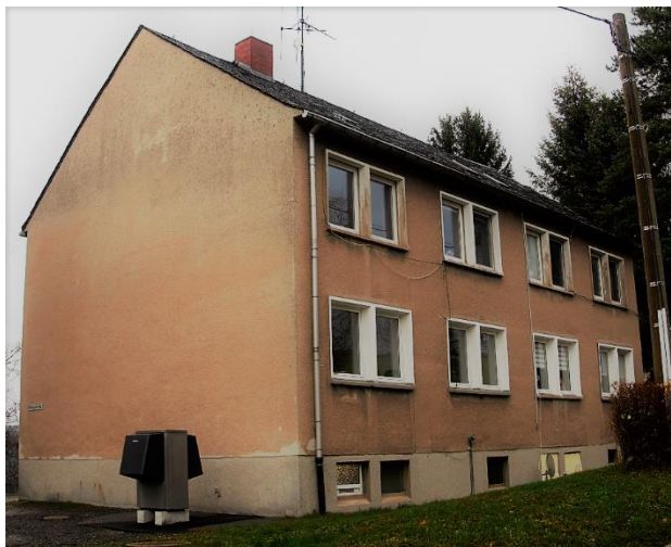
Abbildung 72: Ansicht Demonstrationsobjekt Adorf von Süd-West vor der Hüllsanierung mit der neu errichteten Wärmepumpe.
