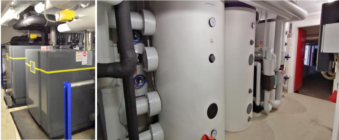
Abbildung 94: Wärmepumpen (links) und Speicher (rechts).
