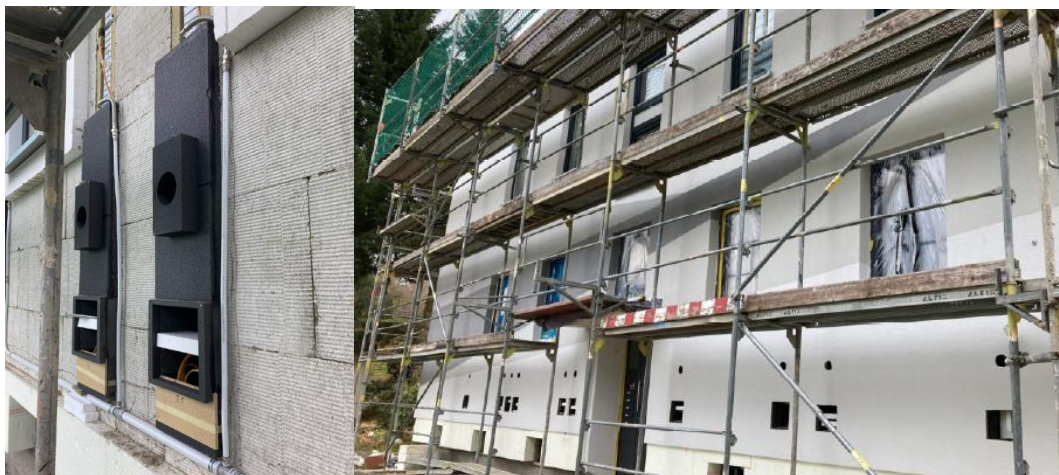
Abbildung 83: Einbausituation der Lüftungsgeräte im Sockelbereich.
